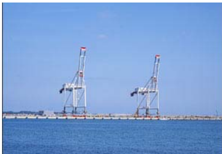
海から見たガントリークレーン
