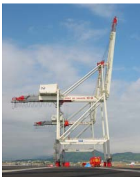
ガントリークレーン
